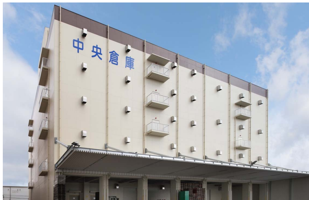
京都支店城南営業所A・B号倉庫 (京都市伏見区)
