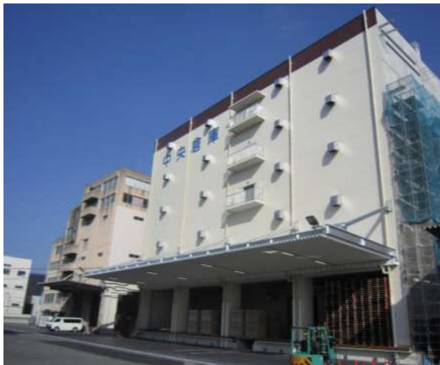
京都支店城南営業所A号倉庫 (京都市伏見区)
